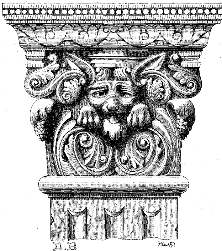
CHAPITEAU DU SOUBASSEMENT DU CHŒUR
