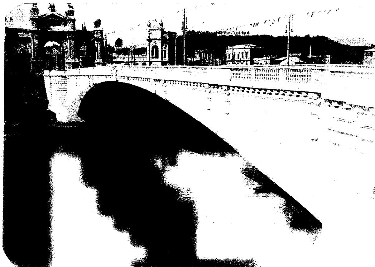
PONT EN BÉTON ARMÉ SUR LE TIBRE, A ROME, DE 100 MÈTRES DE PORTÉE LIBRE
