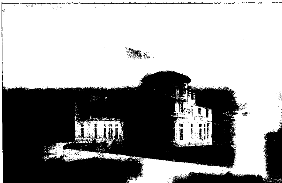
PIERRE BLEIN. — Château de Valensolles.
