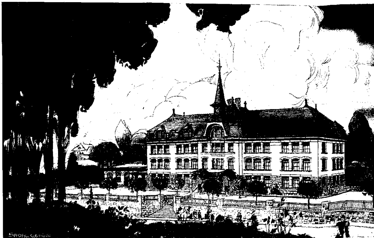
Collège primaire de Prélaz, à Lausanne : vue postérieure.
