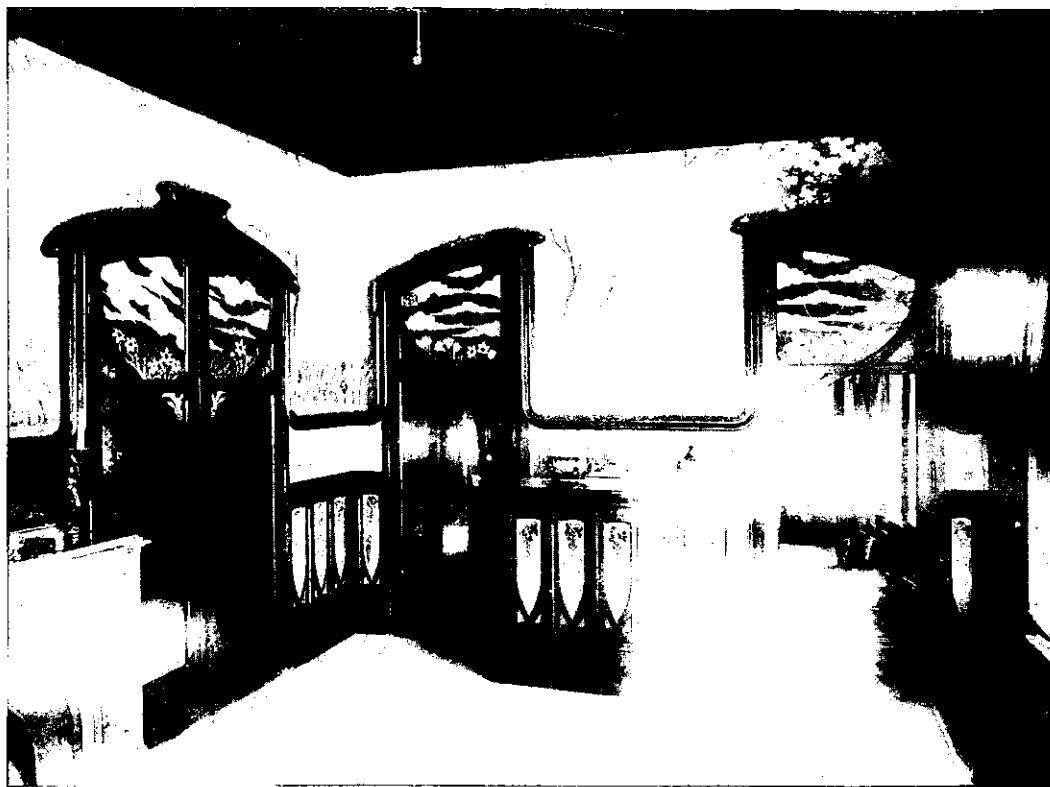
VILLA DES MEULES A COGNY. — Architecte M. Eugène MÉHU Salle à manger Vitraux de M. Lucien BÉGULE. — Peintures décoratives de M. Louis BARDEY.
