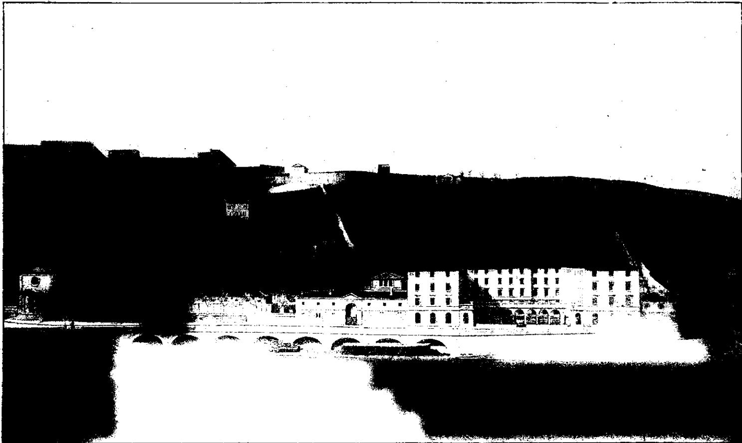
Vue générale actuelle de l'Ecole nationale vétérinaire de Lyon (côté oriental).
